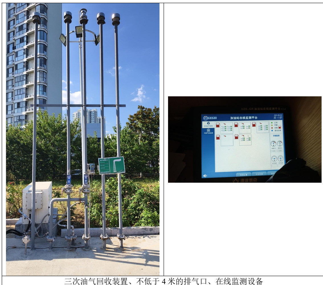
图 4-1 项目废气污染防治措施
