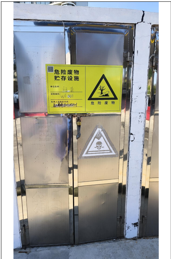
图 4-2 危险废物暂存间
